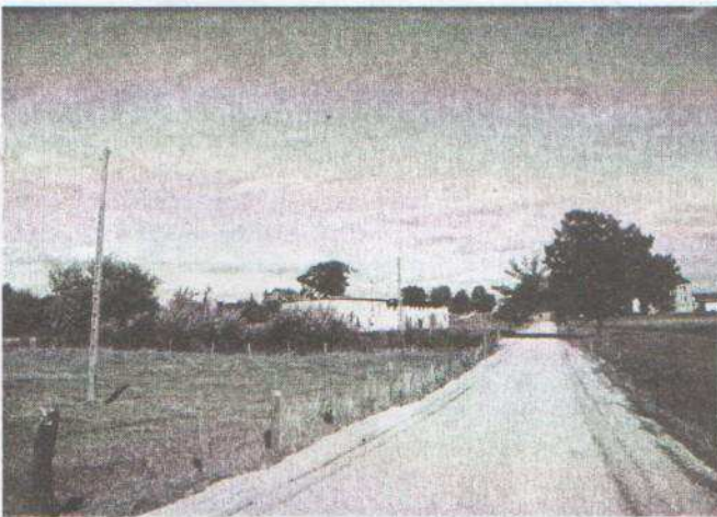
Fragment nowej drogi
