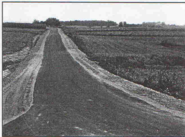
Asfaltowa droga do Rumiejek
