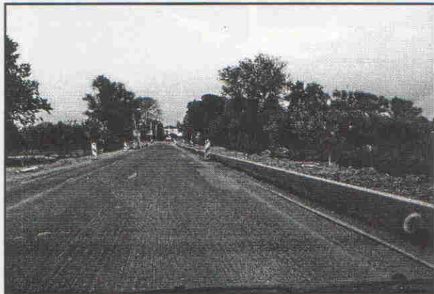
Ulica Warszawska w przebudowie
