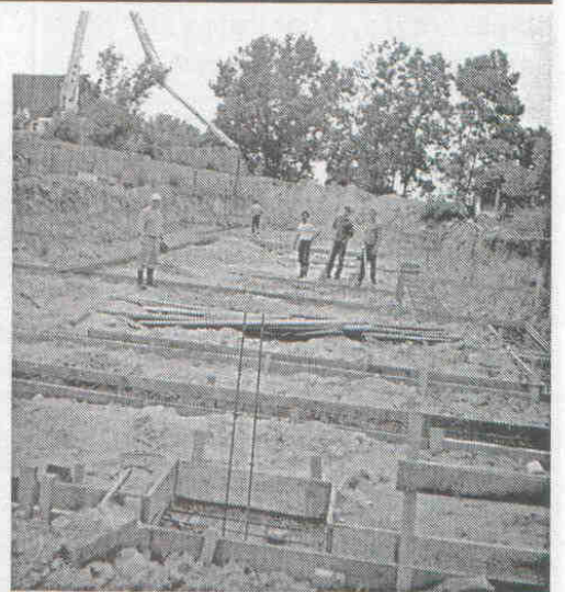
Ruszyła budowa Domu Katolickiego przy parafii Rajgród 12 lipca 2004 r. Ksiądz dziekan rajgrodzki z parafianami na budowie
