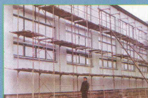
Trwa budowa hali sportowej przy Gimnazjum w Rajgradzie
